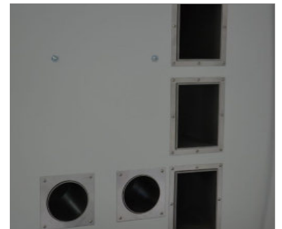
Fori di accesso ulteriori realizzabili in quasi tutte le dimensioni e posizioni
